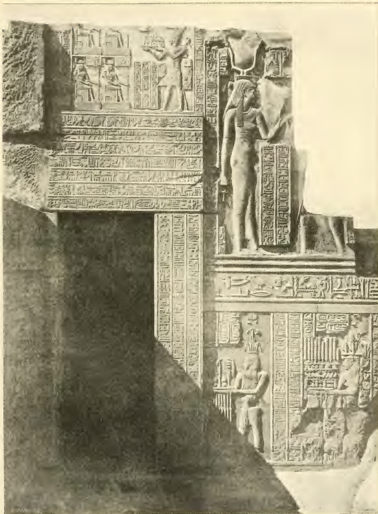
Porte de l'escalier du pylône.
